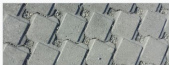
#7 Belegningsstein med drenerende og NOx-reducerende egenskaper →
